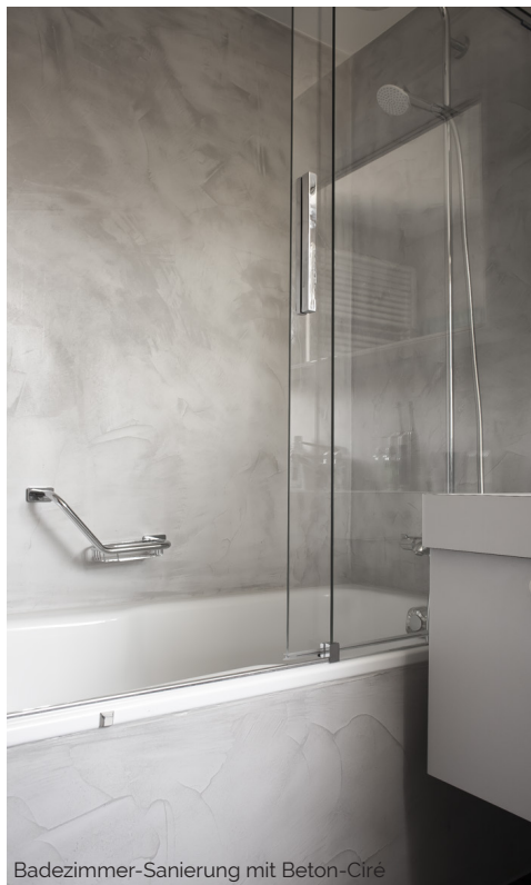
Badezimmer-Sanierung mit Beton-Ciré
